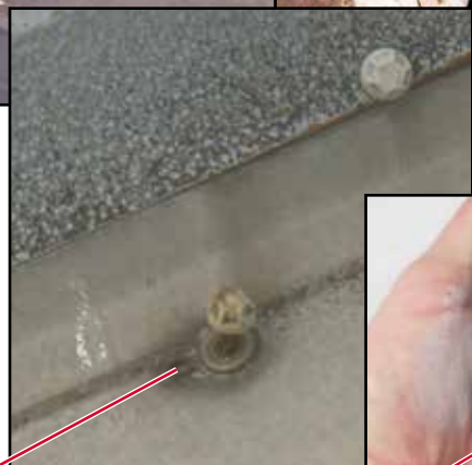
Bavettes et manchons défectueux
