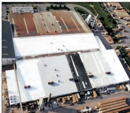
Toiture écologiquement saine et anti-chaleur – pas de rouille!
